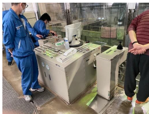
函館日乃出清掃工場の見学の様子
