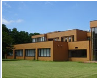
札幌校福利棟（昭和61年築） 鉄骨造2階建 延べ床面積1,434㎡
