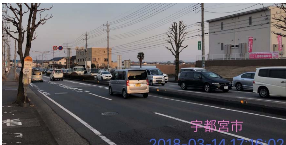
路面電車新設予定地
